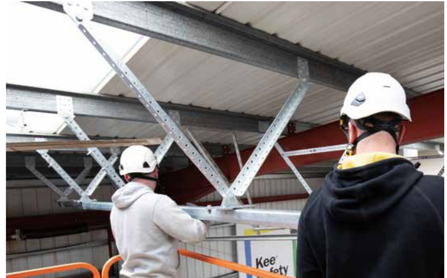
两名安装人员使用一个高架平台将轨道固定在屋顶基础设施上。
