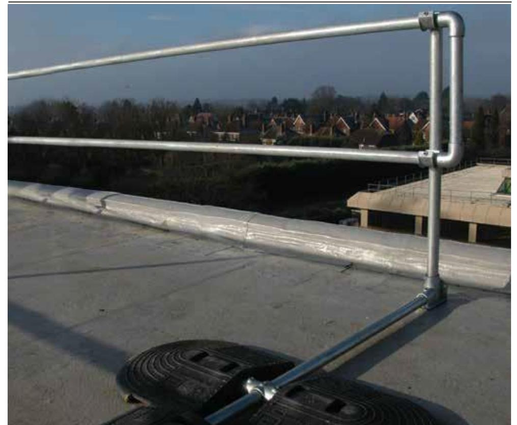
替代方案：在无法使用回弯的情况下，可使用 Kee Guard 配重块。
