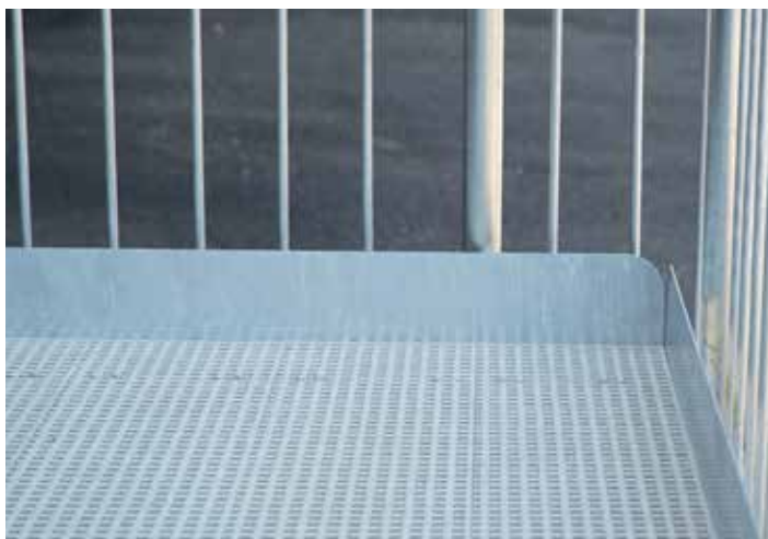
Aufkantung – Kantenschutz, der den Benutzer am Zugangsweg entlang führt
