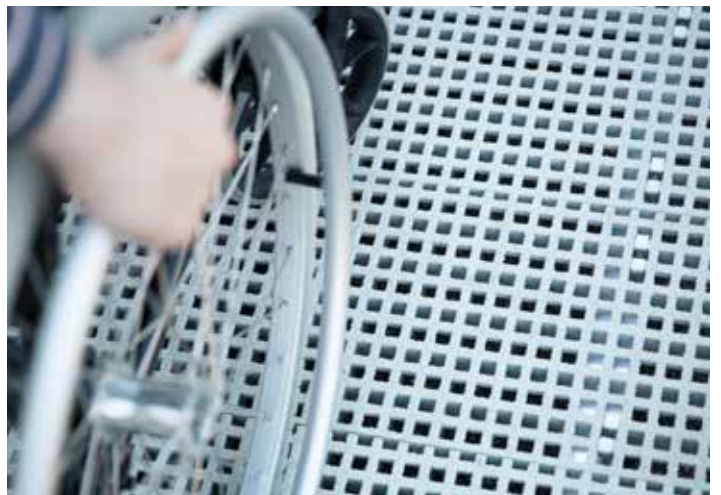
GFK-Laufsteg – Rutschfeste Mini-Netzstruktur macht die Rampe für alle Wetterbedingungen geeignet
