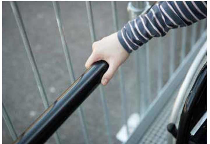
Handlauf – Glatter, durchgehender, pulverbeschichteter Handlauf, der sich bei Berührung nicht kalt anfühlt
