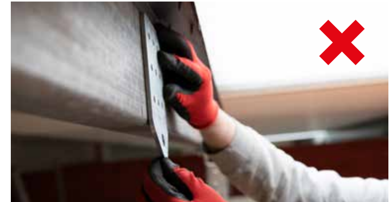
Abb. 1: Falsch - Halterung ist zu Ihnen gebogen
