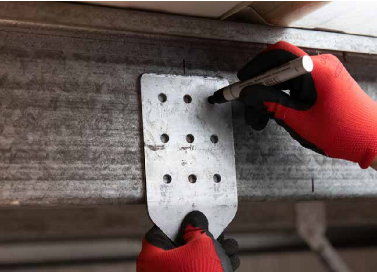
Abb. 1: Falsch - Halterung ist zu Ihnen gebogen
